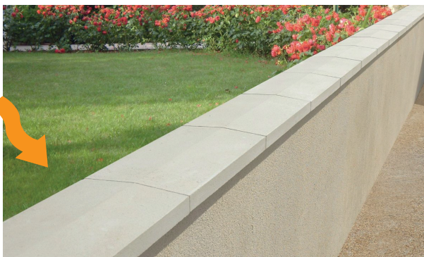
Capa de muro tipo Telhadinho, com Pingadeira.
