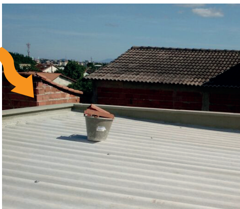
Capa de Muro plana com pingadeira, arrematando telhado embutido.
