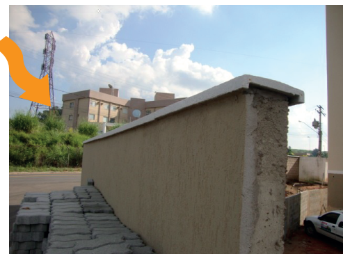
Capa de Muro com Degrau, arrematando muro.
